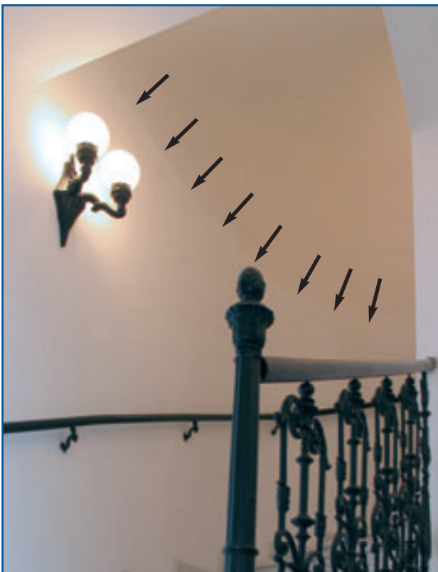
Im oberen Bild ist deutlich die Trennlinie zwischen dem neuen und dem ersten Sanierputz zu sehen, nachdem die Kellerfeuchte bis in den ersten Halbstock aufgestiegen war und den ursprünglichen Sanierputz zerstört hatte.
