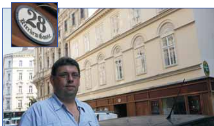
GF Christian Mategka vor dem erfolgreich sanierten Objekt
