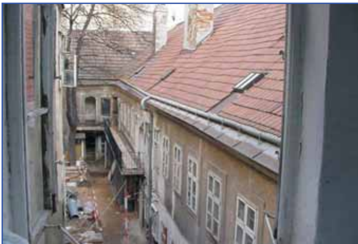
Das Gebäude vor der Trockenlegung und der Sanierung
